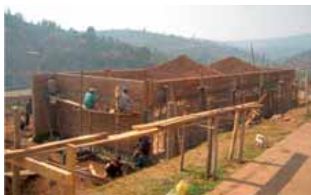
Construction des nouvelles classes
