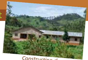
Construction du nouveau Centre Médico-chirurgical
