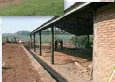
Nouvel hangar (maçonnerie)
